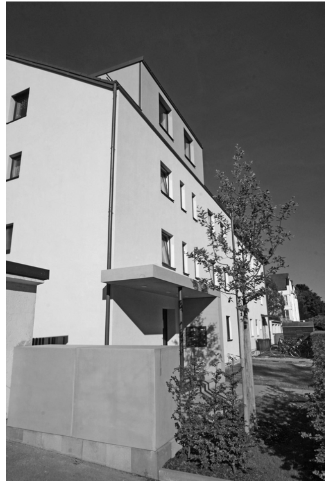
Bild 9: Nach Fertigstellung, östliche Gebäudeecke mit Eingangsbereich
