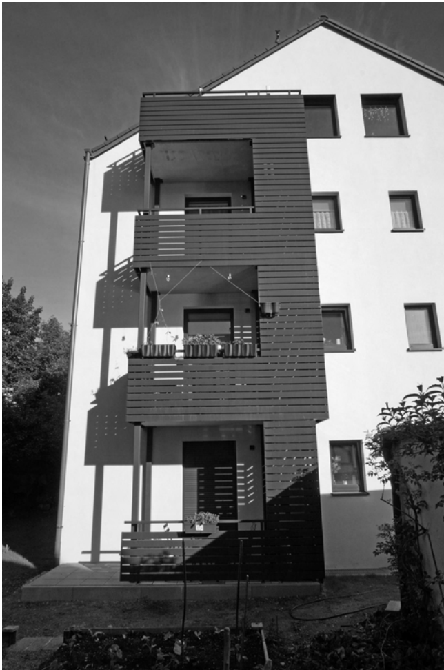
Bild 10: Nach Fertigstellung, südöstlicher Gebäudegiebel mit Balkonanlage
