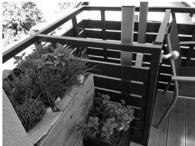
Bild 12: Balkon im Dachgeschoss mit Notleiter
