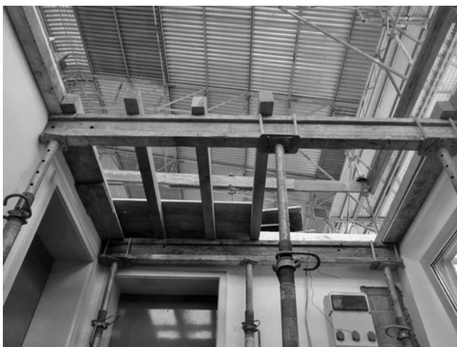
Bild 8: Während der Baumaßnahme, Entnahme der Deckenfelder
