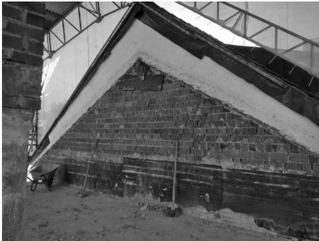
Bild 7: Während der Baumaßnahme, Wand zum Nachbarn
